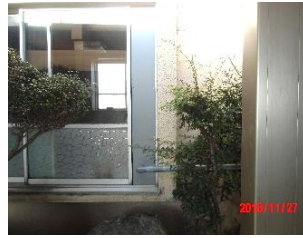
(外側) 外の給水管から接続
