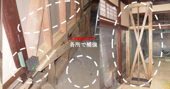
基礎材を組み直し床底全体を新たな基礎とするため鉄筋を入れコンクリートで打設しました。また耐震壁ボード、筋交、止め金具などで各所を補強しました。耐震補強だけでなく、天井・壁・床など断熱材で熱効率を上げ住み心地をよくしました。
