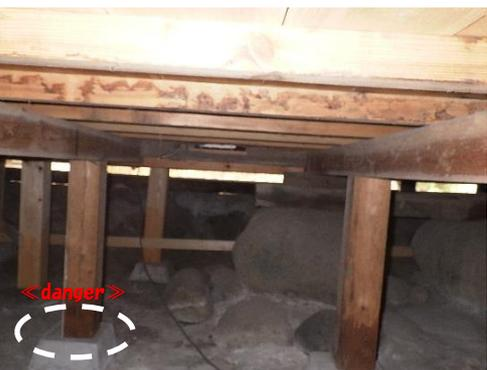
白壁の大きなお宅、柱や梁は太く立派なもの、かっこいいですよね～、これだけのものを今作るのは中々大変なことです。建築年数は築 67 年、在来軸組工法で出来ています。床下に潜ると、これも立派柱です。しかし基礎柱は石の上に乗っているだけ、これでは地震の時に大変なことになるかもしれません。各所点検を行い耐震補強をすることになりました。同時に 2 世帯住宅リフォームの希望を受けて作業開始です。
