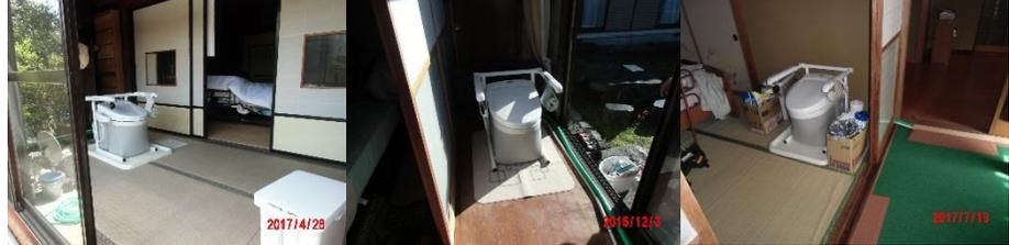
便器と排水管をホースで接続。便器と給水管を配管で接続。
