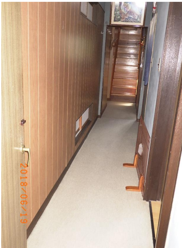
■現状写真■ (工事施工前)
