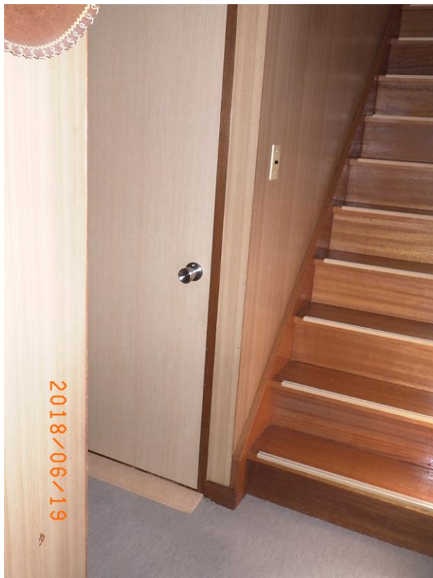
■現状写真■ (工事施工前)
