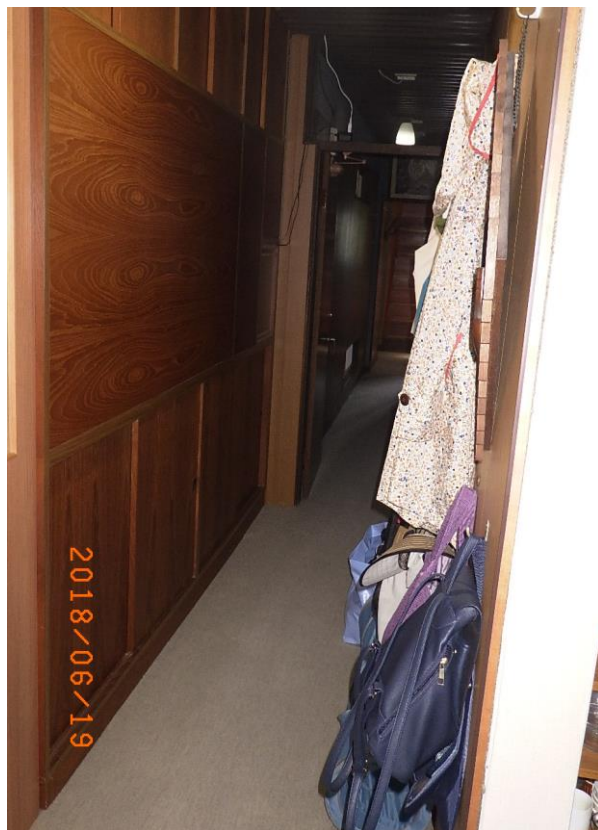
■現状写真■ (工事施工前)
