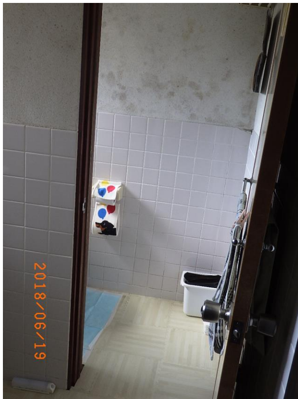
■現状写真■ (工事施工前)
