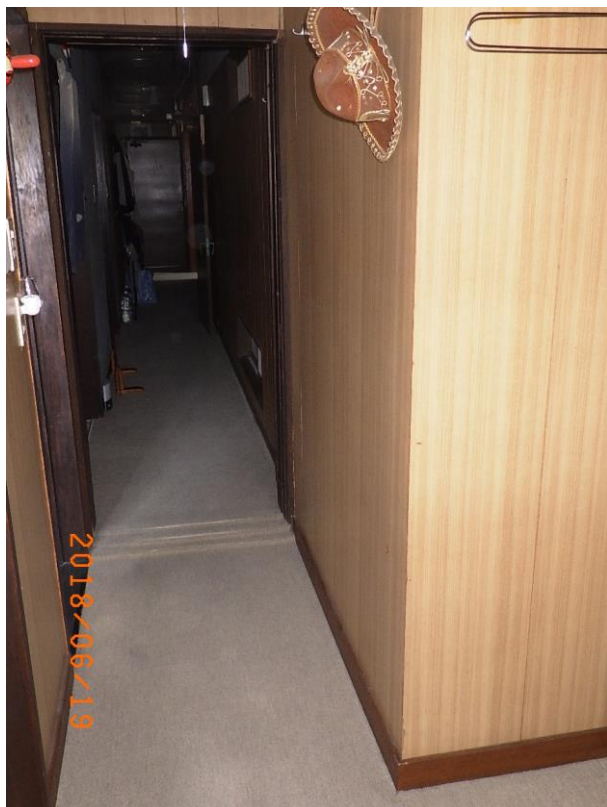
■現状写真■ (工事施工前)
