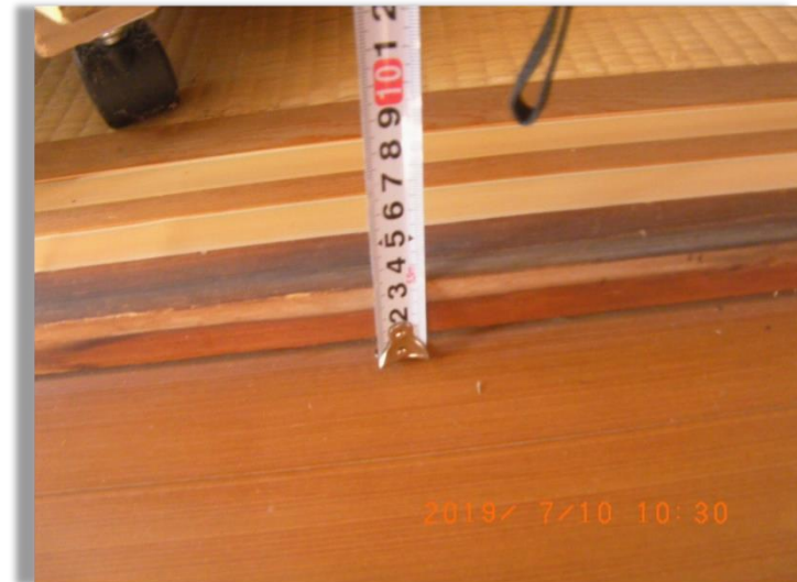
寝室・縁側段差確認写真②
