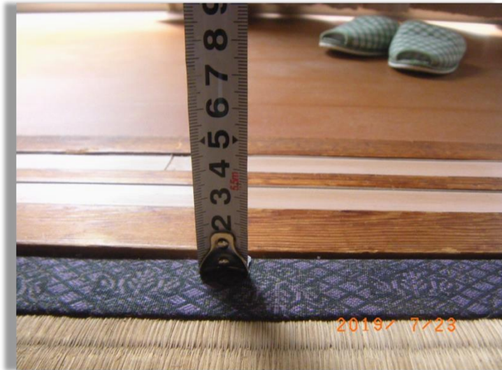
寝室・縁側段差確認写真①
