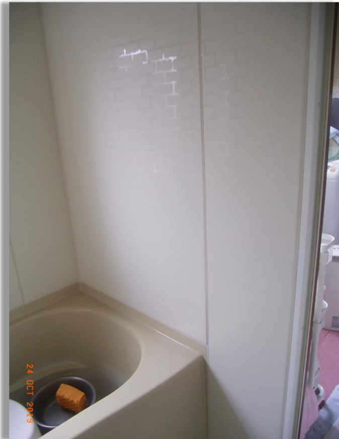
■現状写真■ (工事施工前)
