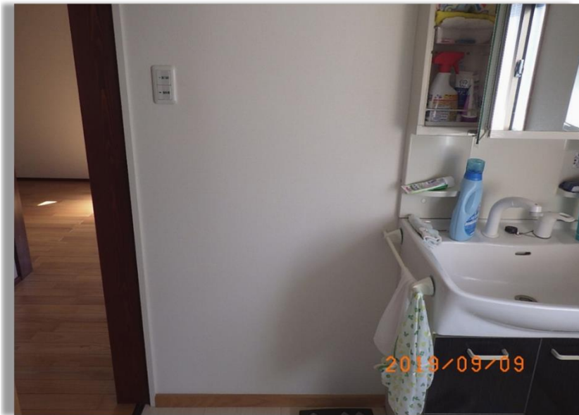
■現状写真■ (工事施工前)
