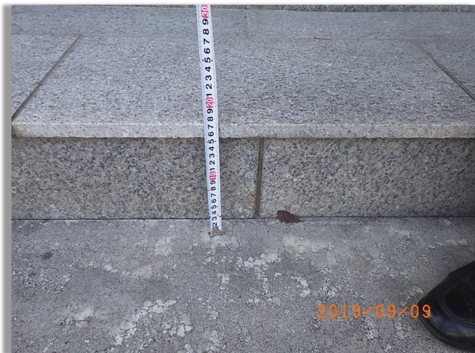
■参考写真①■ 玄関外階段1段目
