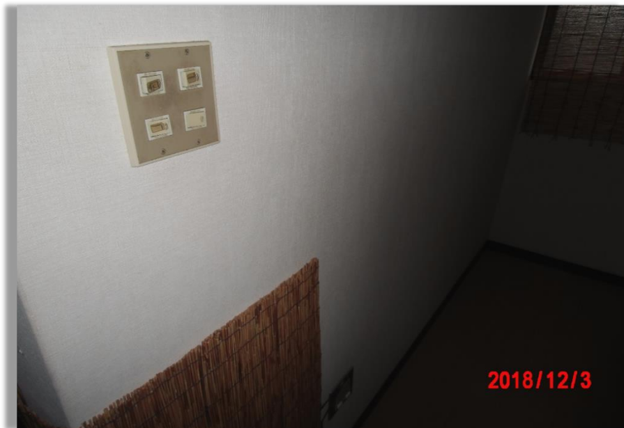
■現状写真■ (工事施工前)
