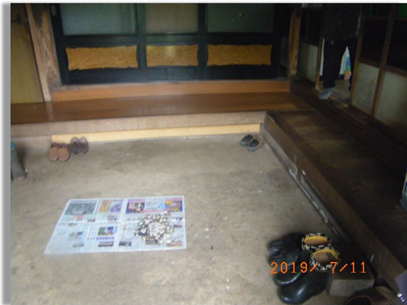
■現状写真■ (工事施工前)
