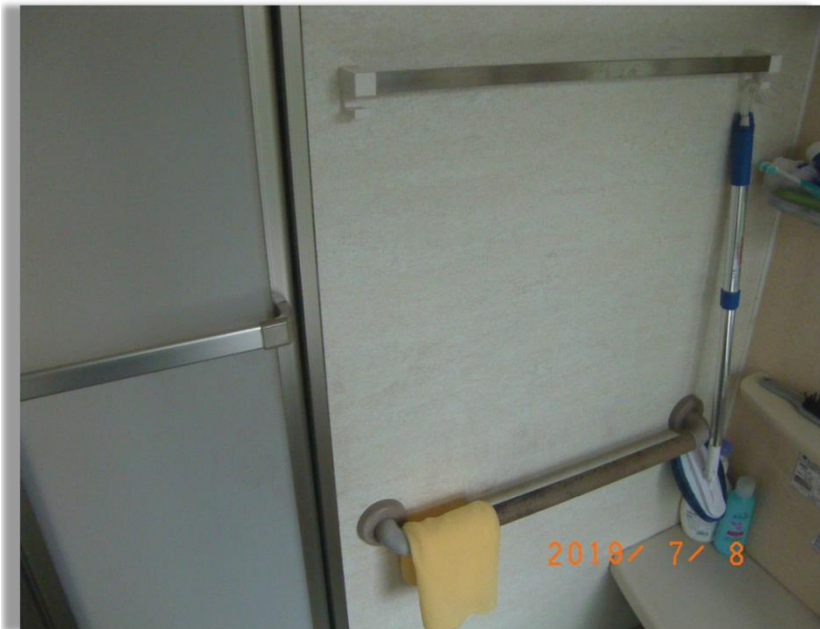
■現状写真■ (工事施工前)
