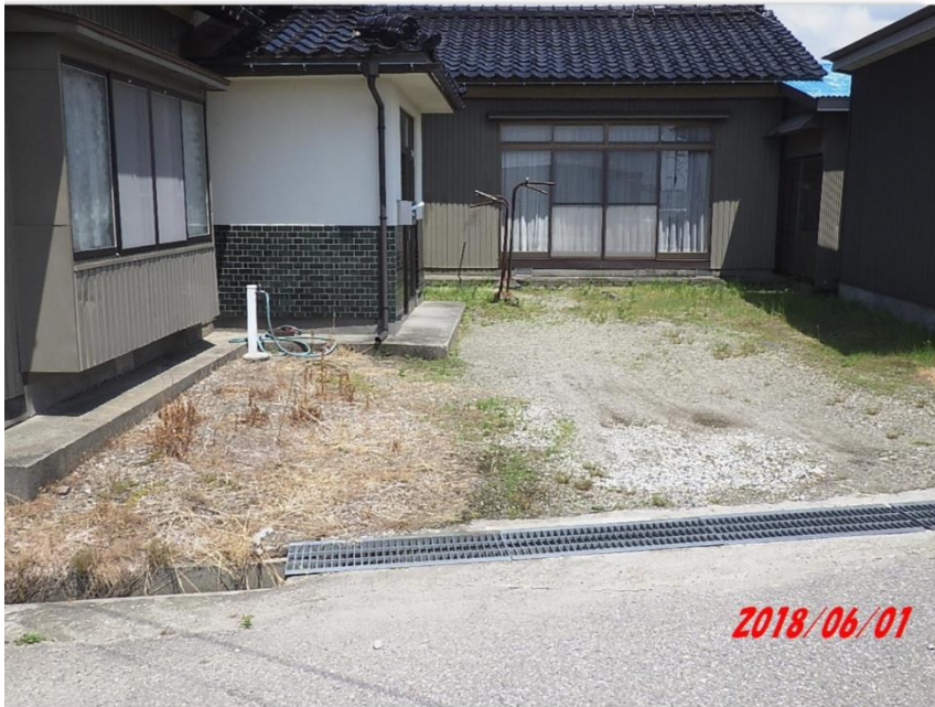
■現状写真■ (工事施工前)
