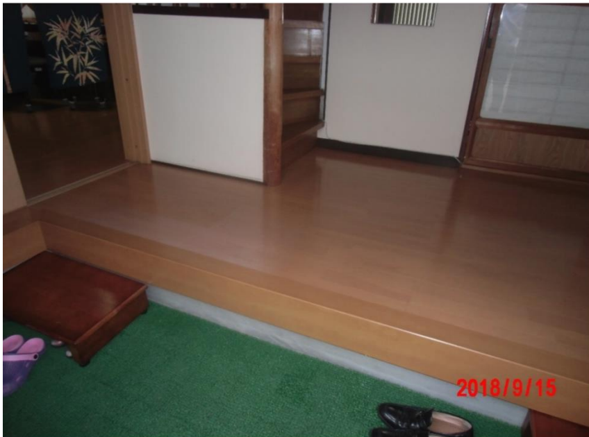
■現状写真■ (工事施工前)
