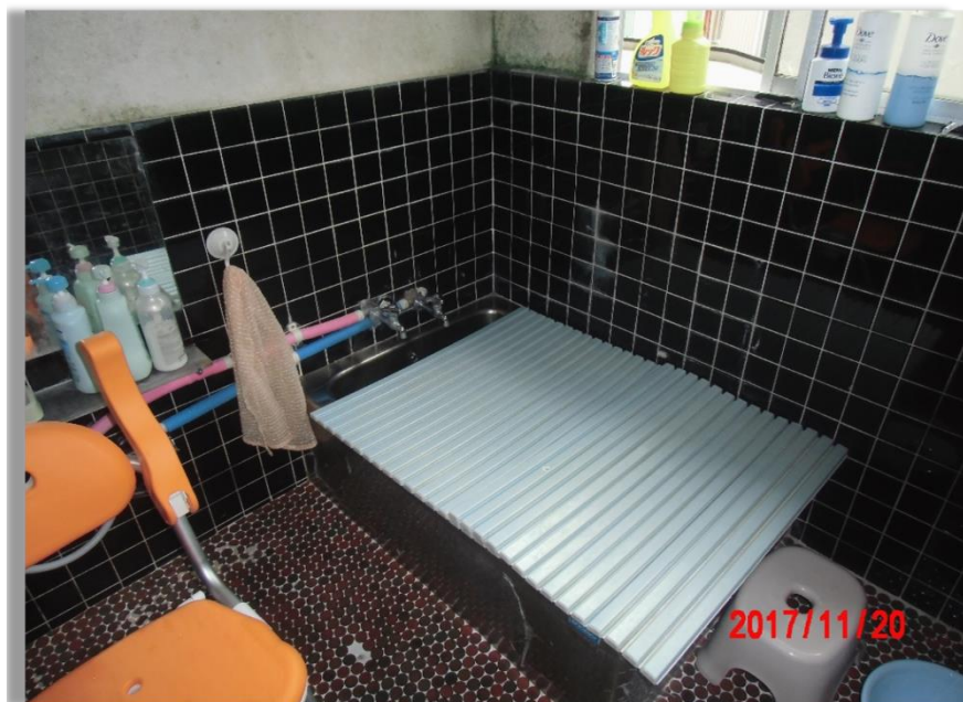
■現状写真■ (工事施工前)
