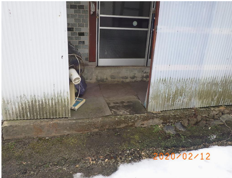
■現状写真■ (工事施工前)
