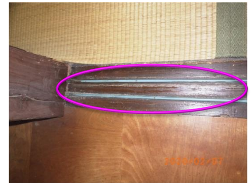
■参考写真(2枚)■ 扉2枚の撤去・レールの撤去
