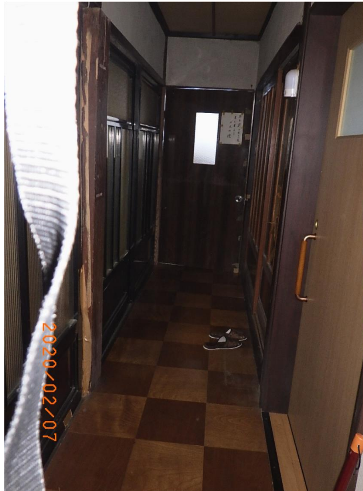
■現状写真■ (工事施工前)
