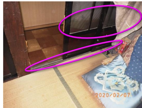
■参考写真(2枚)■ 扉2枚の撤去・レールの撤去
