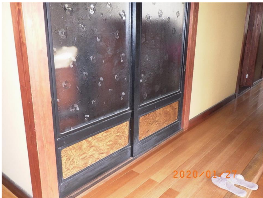
■現状写真■ (工事施工前)
