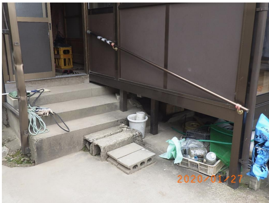
■現状写真■ (工事施工前)
