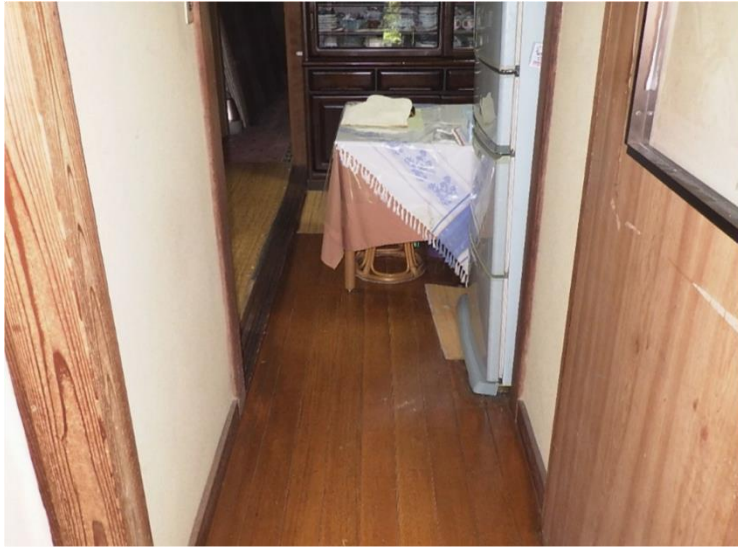
■現状写真■ (工事施工前)
