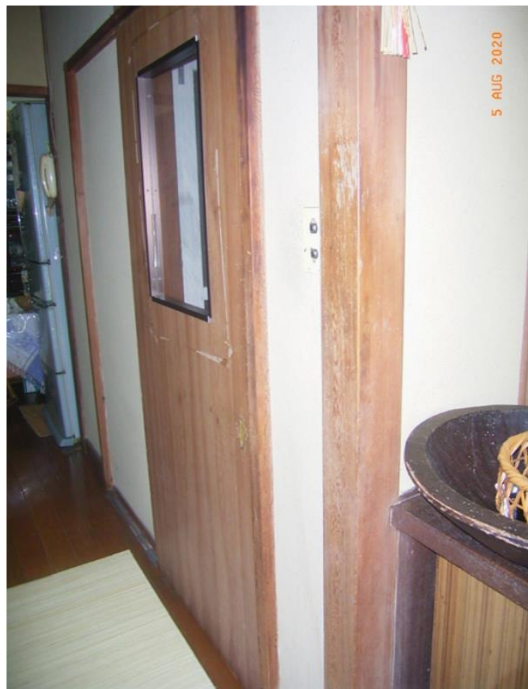
■現状写真■ (工事施工前)
