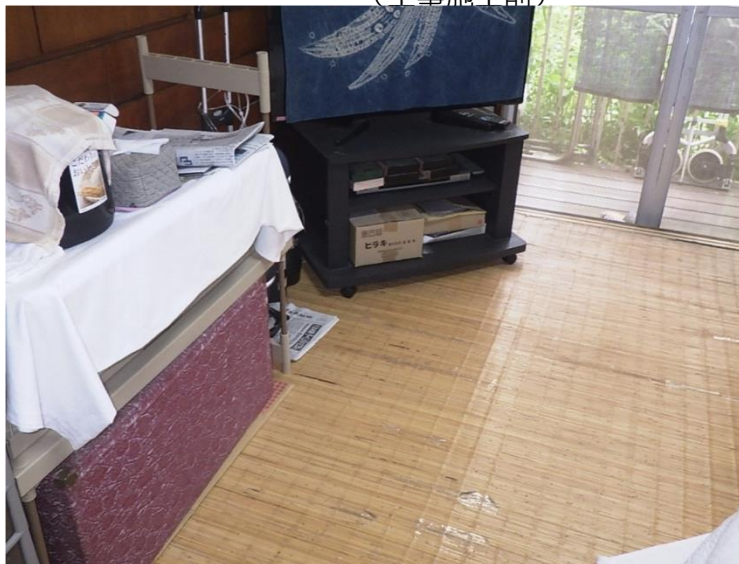
■現状写真■ (工事施工前)
