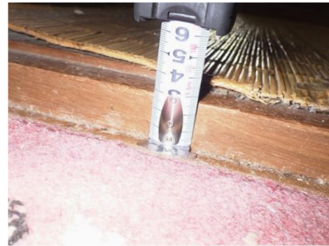
■廊下⇄和室段差■
