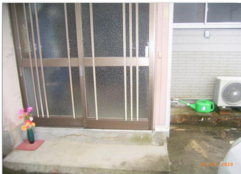
■現状写真■ (工事施工前)
