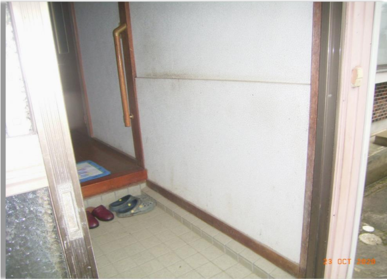
■現状写真■ (工事施工前)
