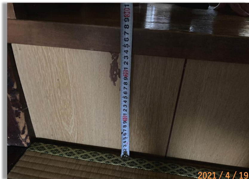
■現状写真■ (工事施工前)
