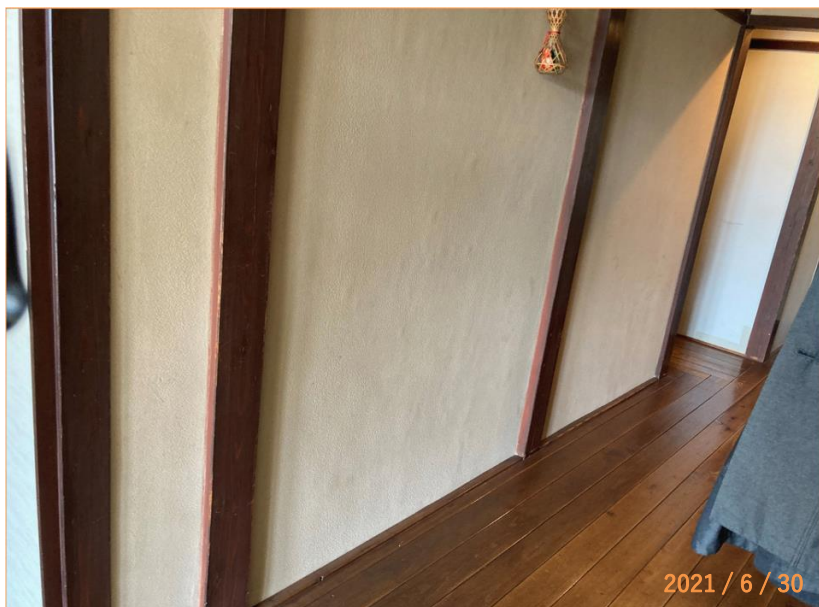
■現状写真■ (工事施工前)
