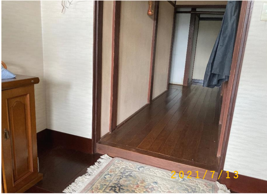
①玄関 廊下 動線段差確認写真
