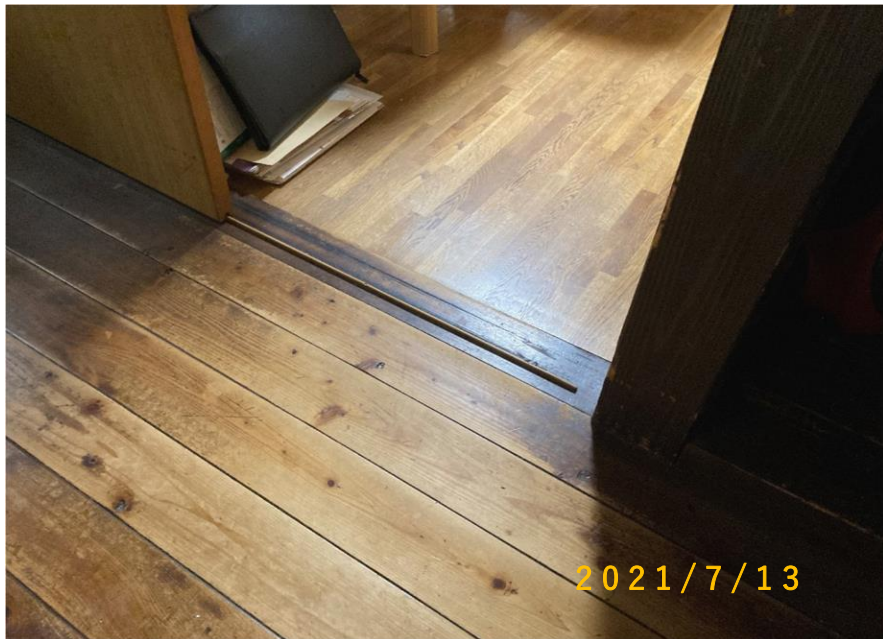
②廊下・リビング 動線確認写真（全体）
