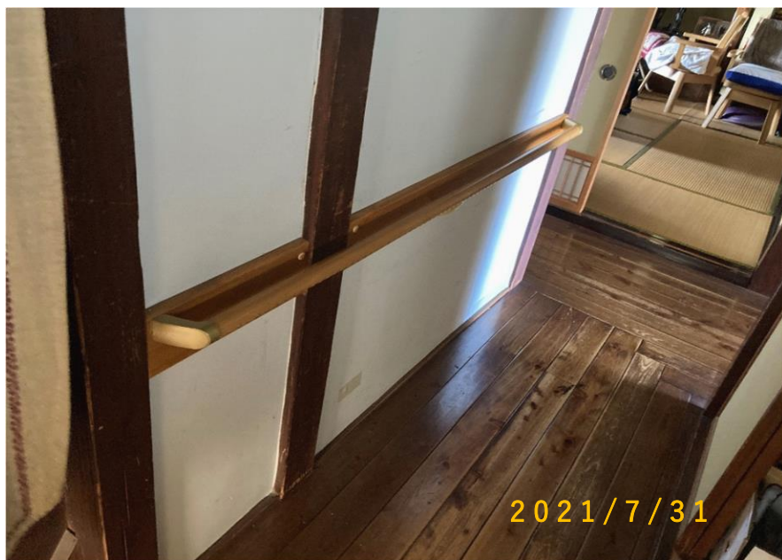
②廊下 手すり 着工後写真
