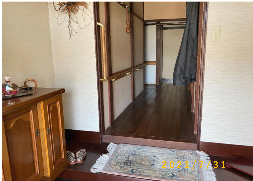
①玄関 廊下 手すり 着工後写真
