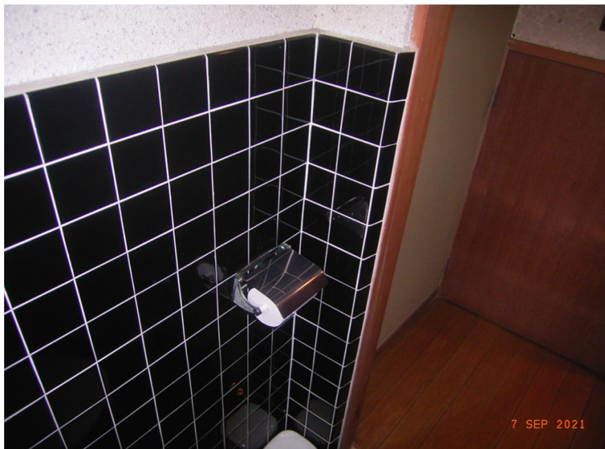
■現状写真■ (工事施工前)
