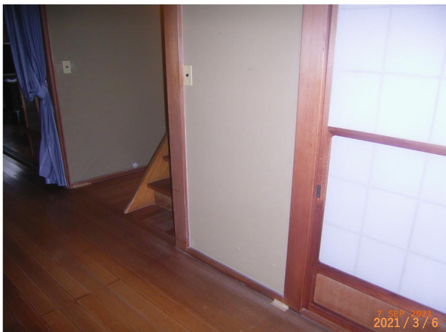
■現状写真■ (工事施工前)
