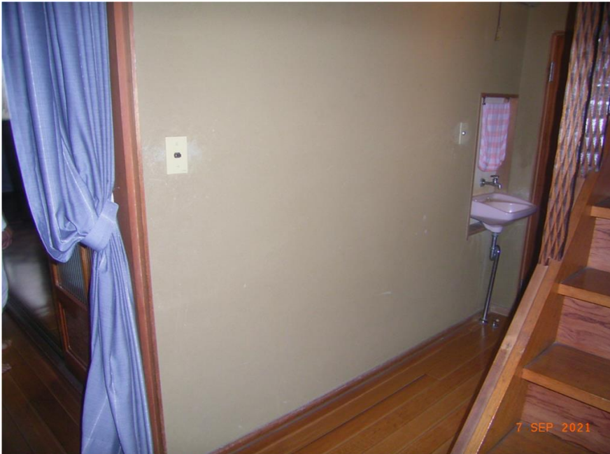
■現状写真■ (工事施工前)
