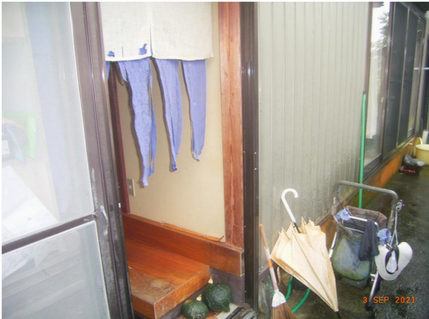
■現状写真■ (工事施工前)
