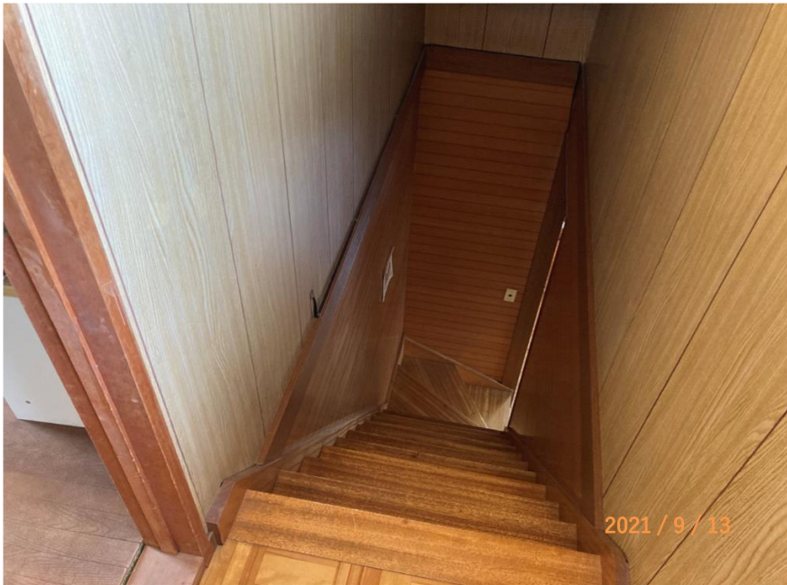
■現状写真■ (工事施工前)
