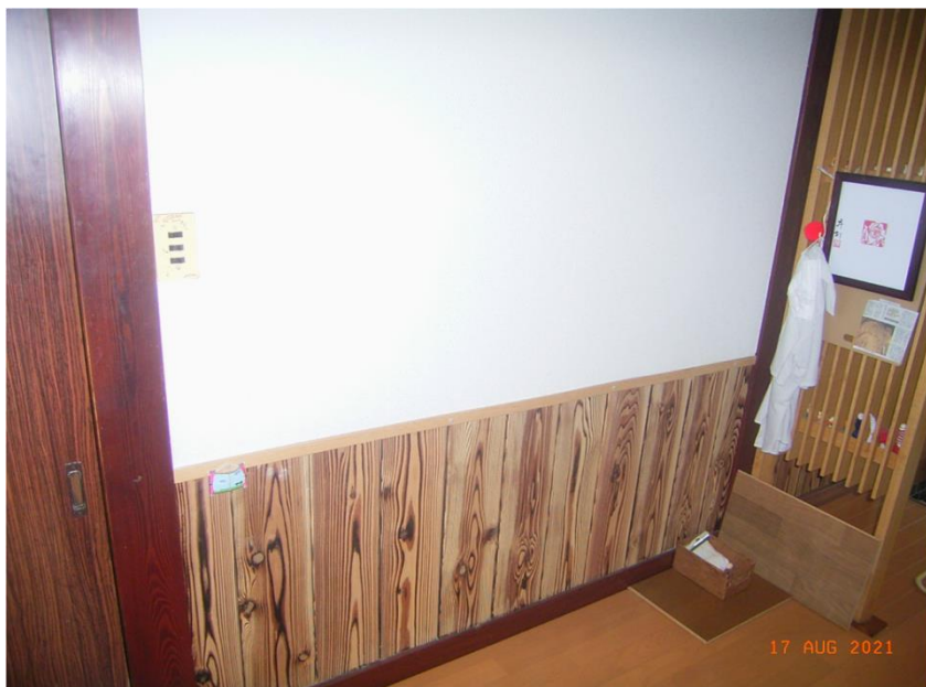
■現状写真■ (工事施工前)
