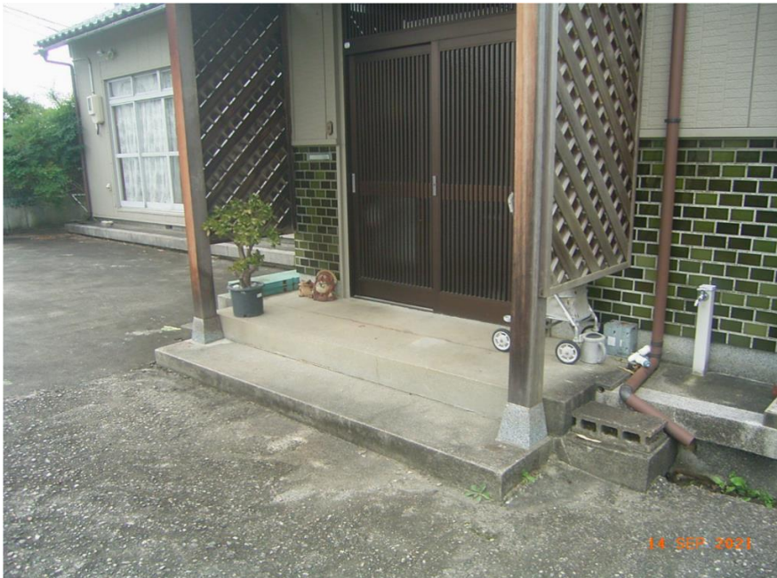
■現状写真■ (工事施工前)
