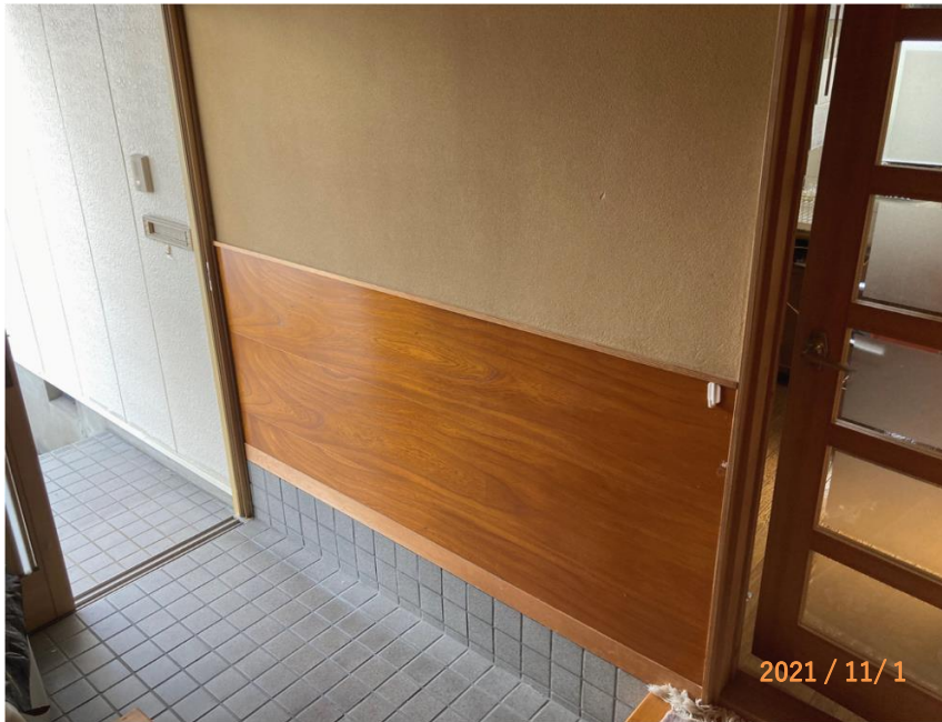
■現状写真■ (工事施工前)
