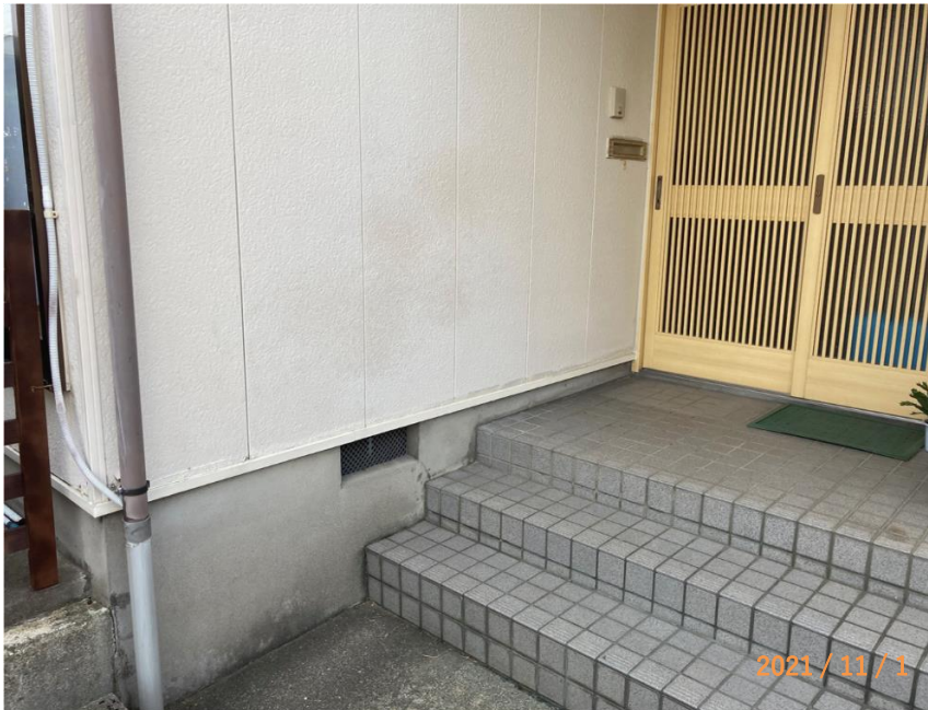
■現状写真■ (工事施工前)
