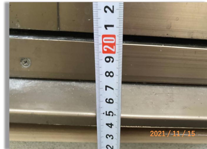
■③勝手口段差参考写真(1)-2■
