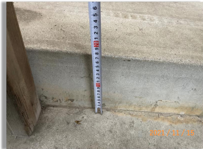
■③勝手口段差参考写真(2)-1■
