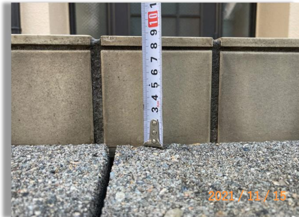
■②玄関外段差参考写真 (1) ■
