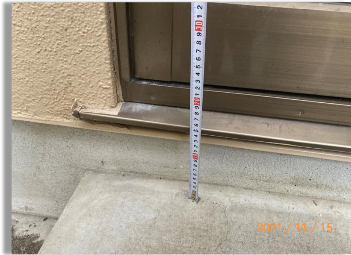
■③勝手口段差参考写真(1)-1■
