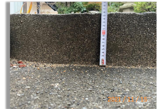
■②玄関外段差参考写真 (3) ■
