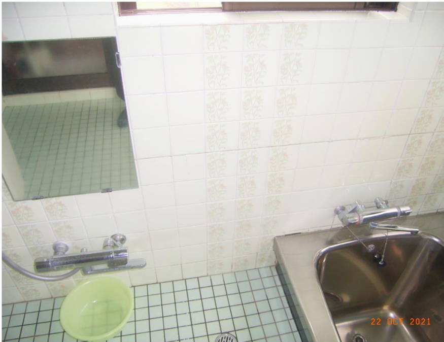
■現状写真■ (工事施工前)
