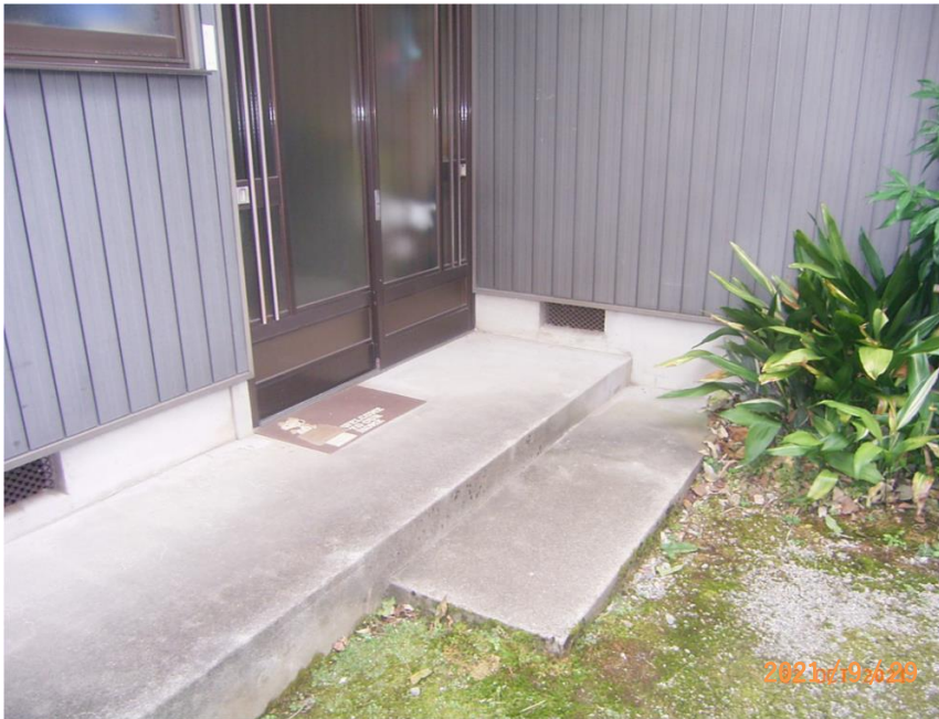
■現状写真■ (工事施工前)
