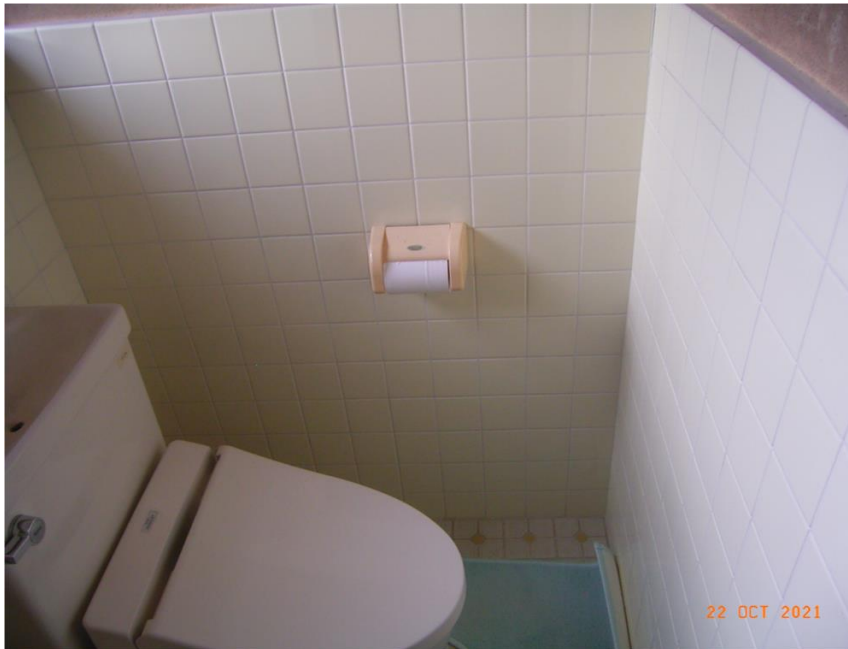
■現状写真■ (工事施工前)
