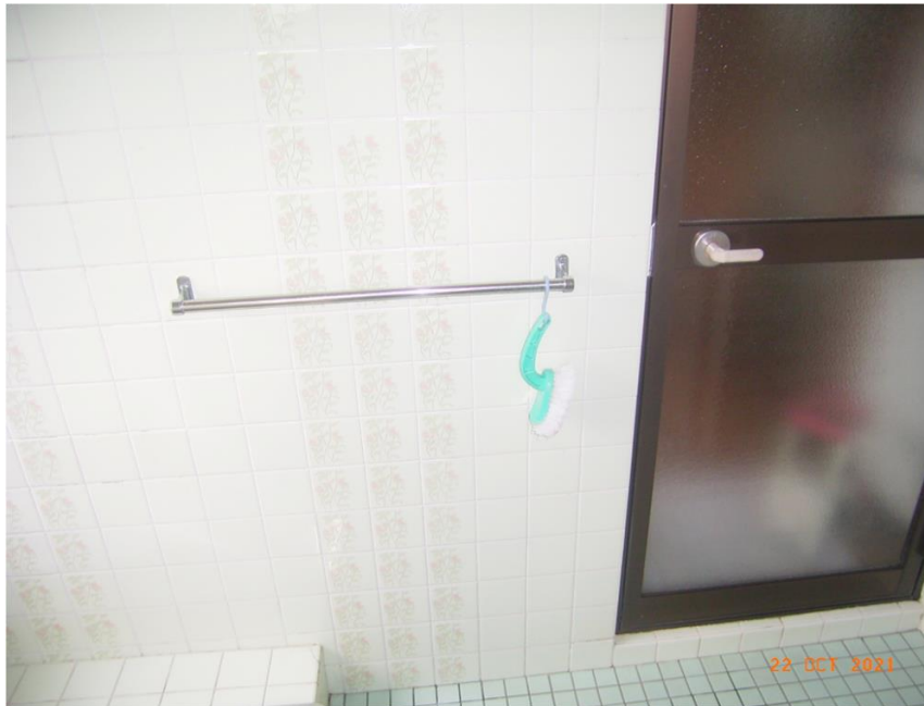
■現状写真■ (工事施工前)
