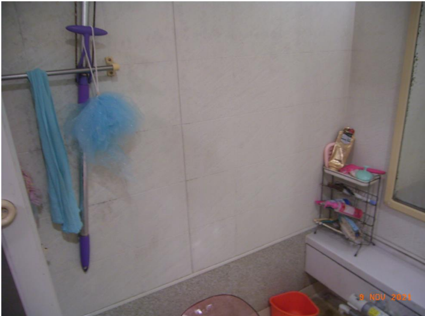
■現状写真■ (工事施工前)
