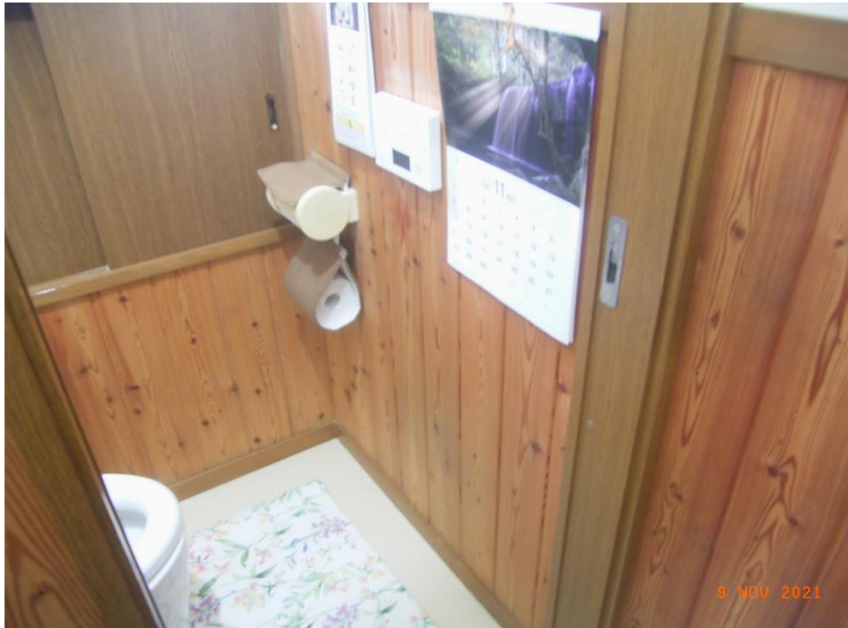
■現状写真■ (工事施工前)
