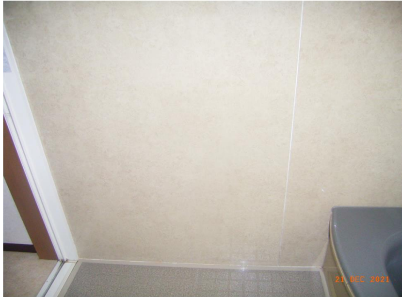
■現状写真■ (工事施工前)
