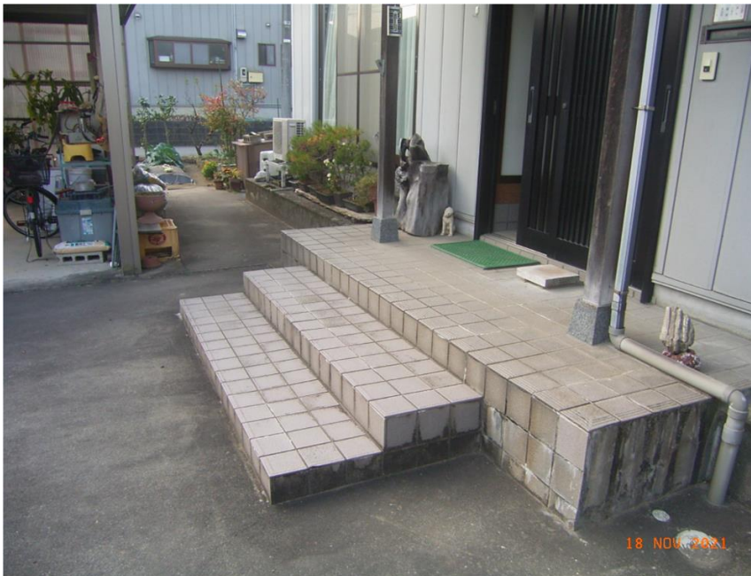
■現状写真■ (工事施工前)
