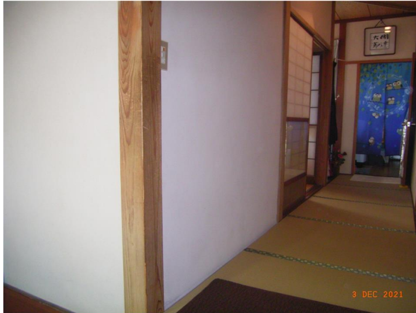
■現状写真■ (工事施工前)
