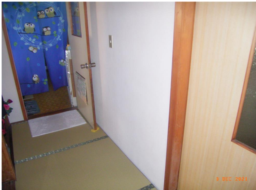
■現状写真■ (工事施工前)
