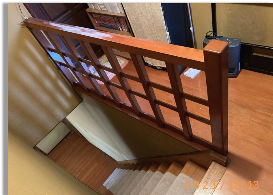
■現状写真■ (工事施工前)
