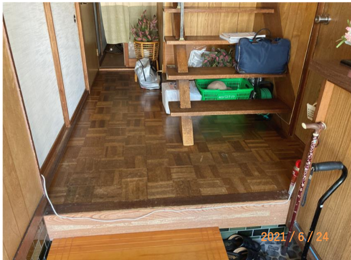
■現状写真■ (工事施工前)
