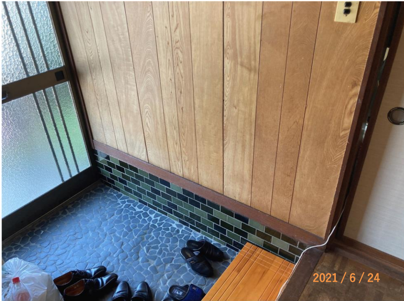
■現状写真■ (工事施工前)
