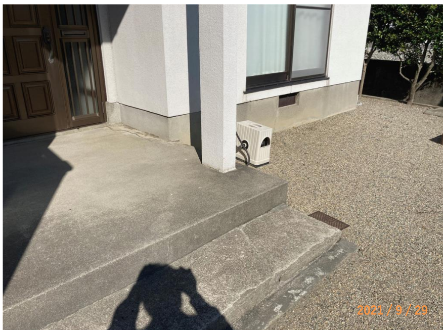
■現状写真■ (工事施工前)
