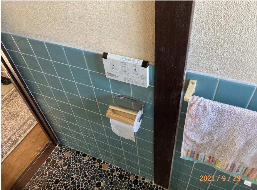
■現状写真■ (工事施工前)
