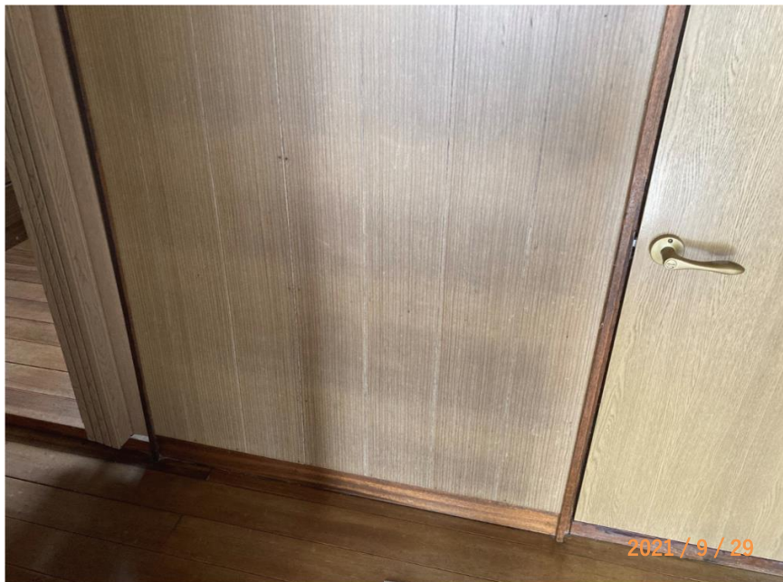
■現状写真■ (工事施工前)
