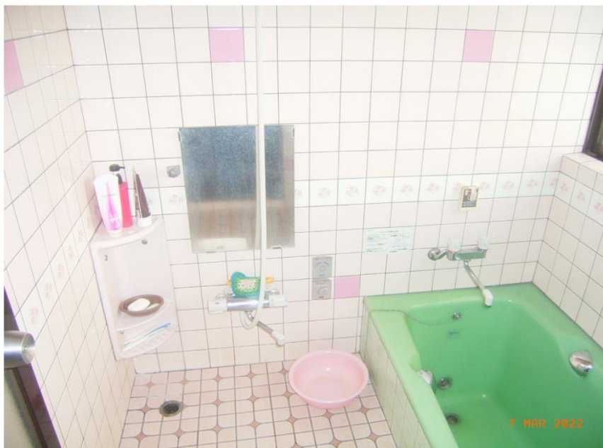
■現状写真■ (工事施工前)
