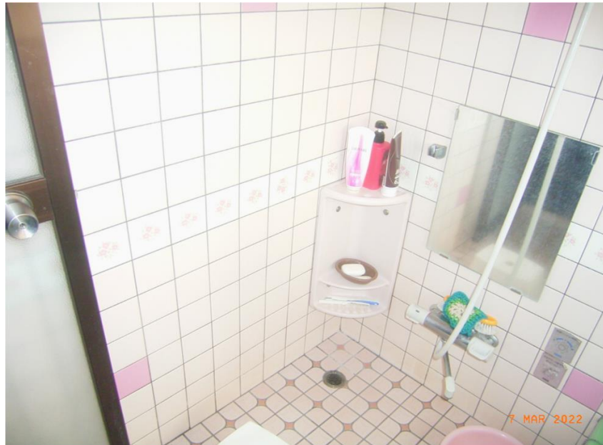
■現状写真■ (工事施工前)
