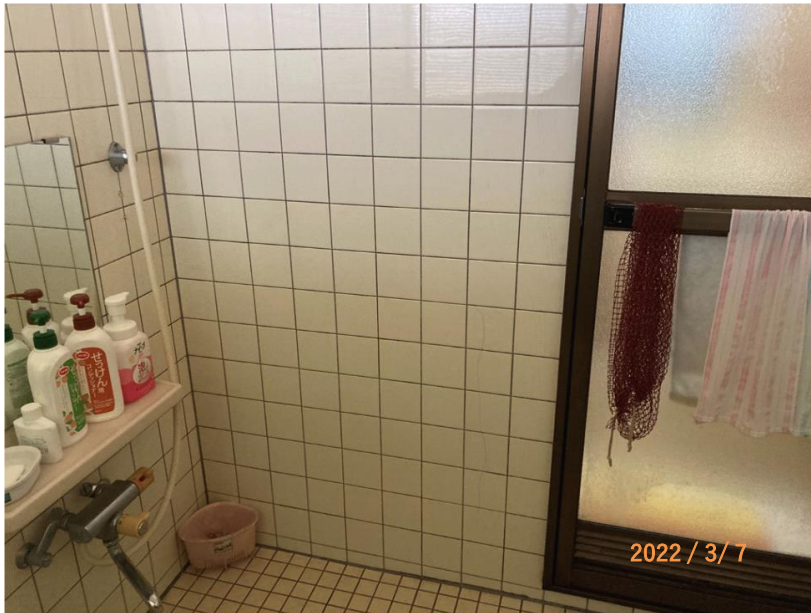
■現状写真■ (工事施工前)
