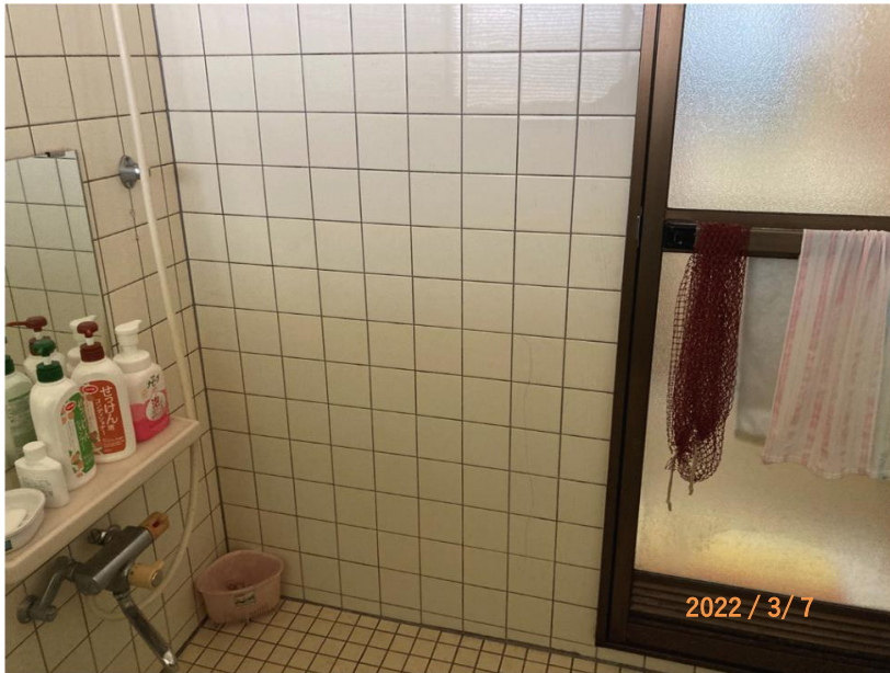
■現状写真■ (工事施工前)
