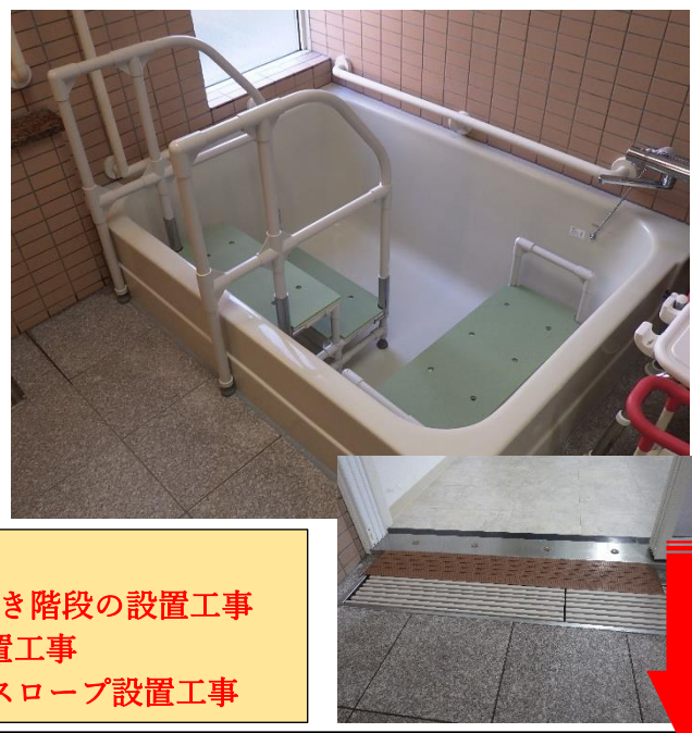
上↑：手すり設置（既存の不足部分追加） 左←：収納棚の新設（オーダー設計）
