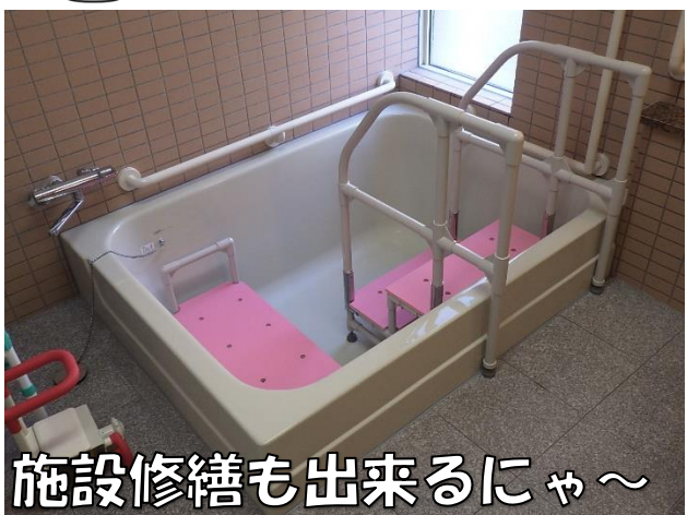
上↑（2箇所） 施設内浴槽 手すり付き階段の設置工事 浴槽内腰掛座椅子設置工事 右→ 浴槽出入口段差解消スロープ設置工事
