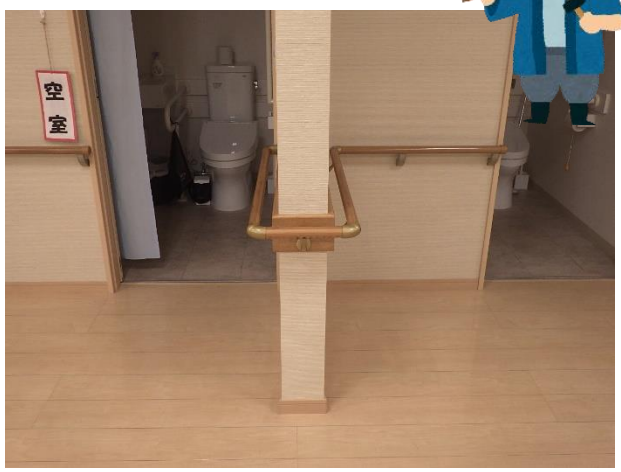
上↑：手すり設置（既存の不足部分追加） 左←：収納棚の新設（オーダー設計）
