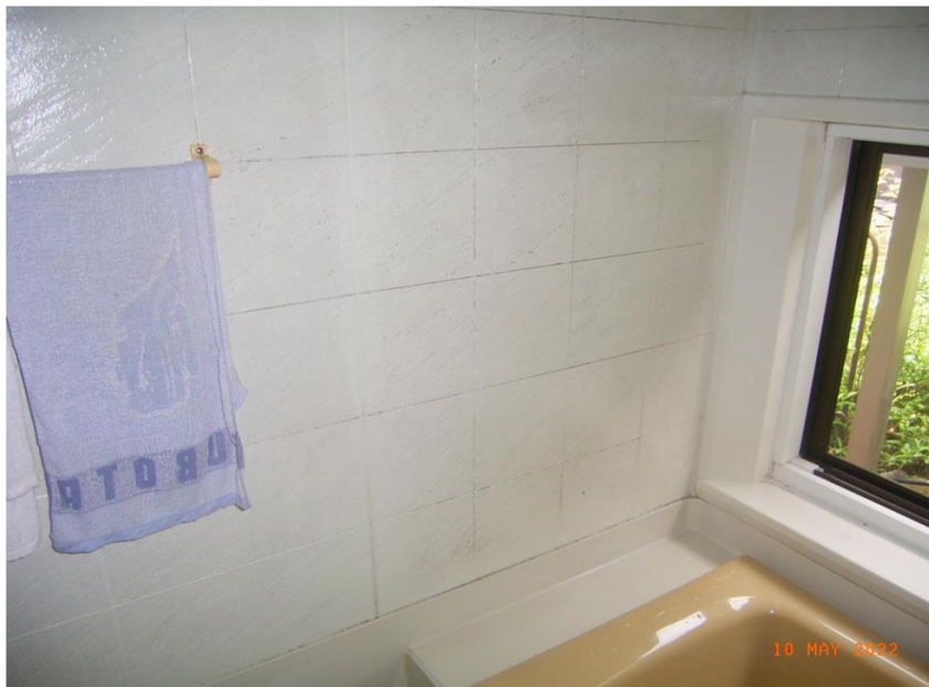
■現状写真■ (工事施工前)
