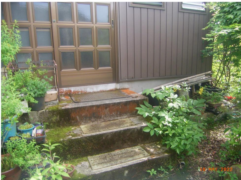
■現状写真■ (工事施工前)
