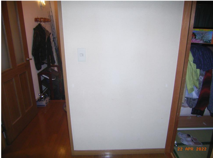
■現状写真■ (工事施工前)
