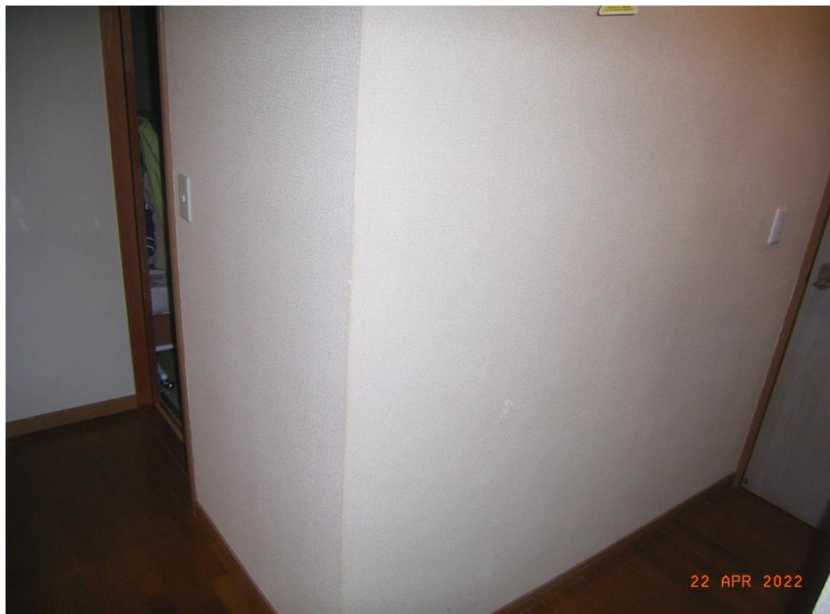
■現状写真■ (工事施工前)
