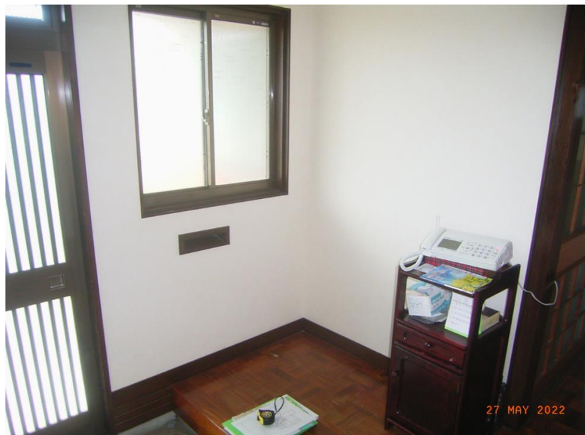
■現状写真■ (工事施工前)
