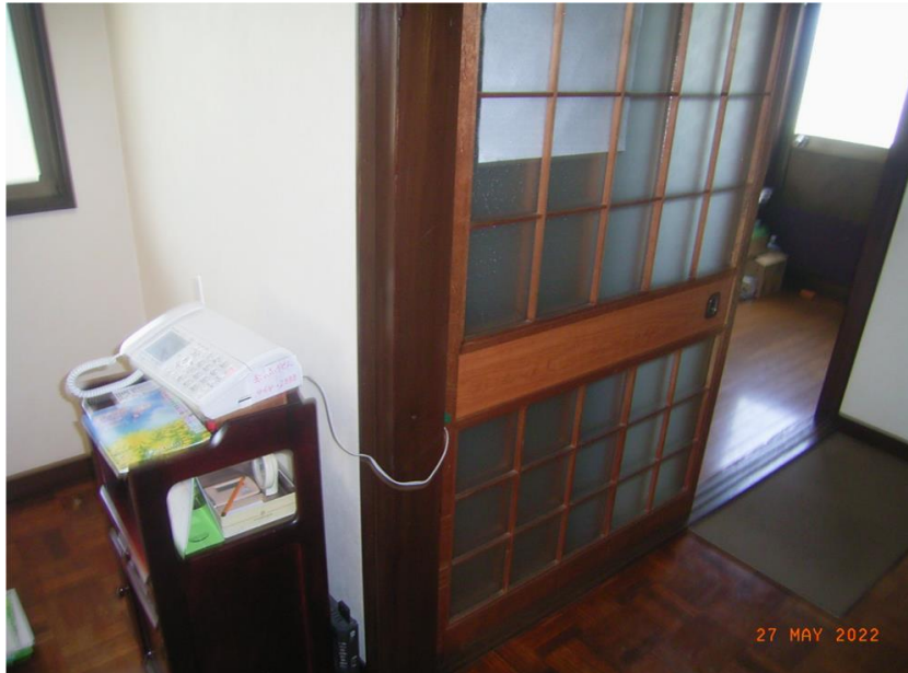
■現状写真■ (工事施工前)
