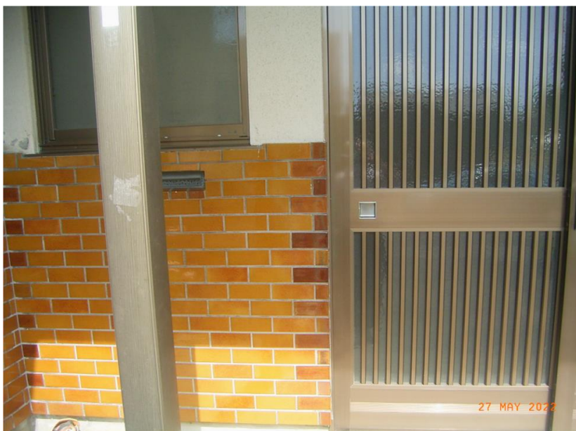
■現状写真■ (工事施工前)
