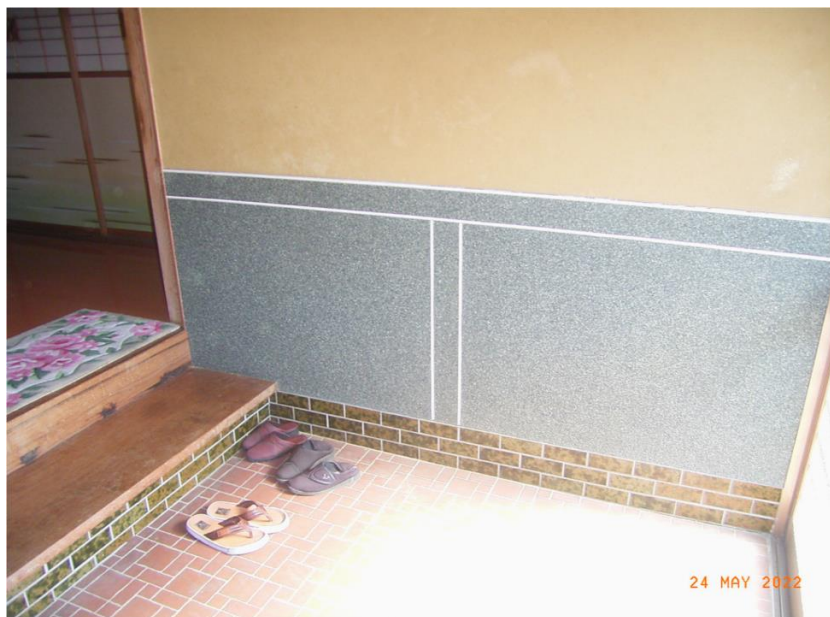
■現状写真■ (工事施工前)
