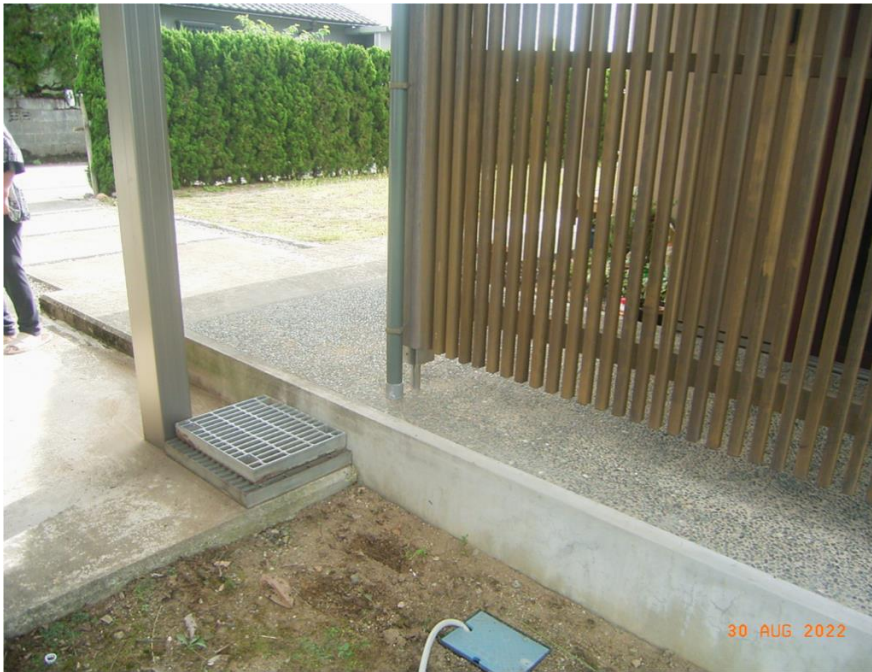
■現状写真■ (工事施工前)
