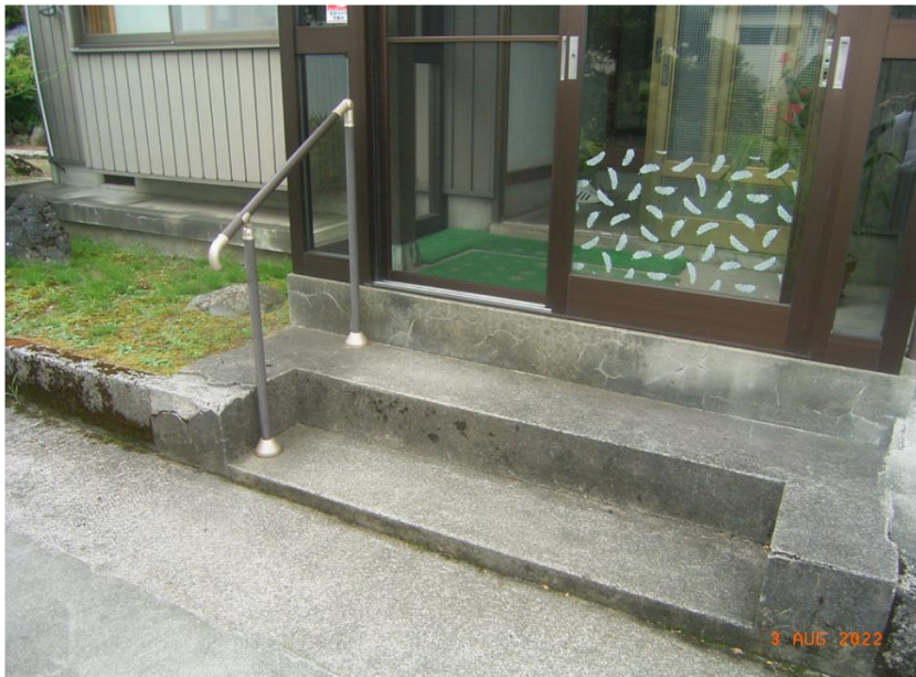
■現状写真■ (工事施工前)
