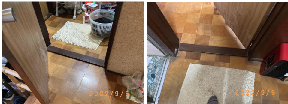
■現状写真■ (工事施工前)
