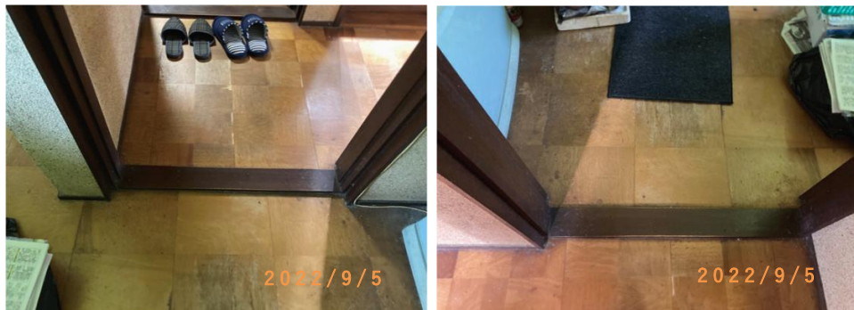
■現状写真■ (工事施工前)
