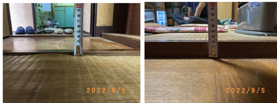
■段差確認■ (工事施工前)
