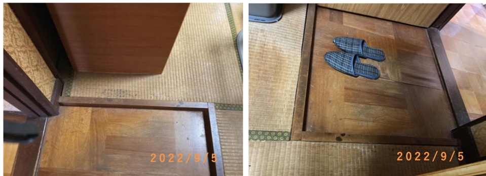
■現状写真■ (工事施工前)
