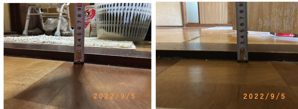
■段差確認■ (工事施工前)
