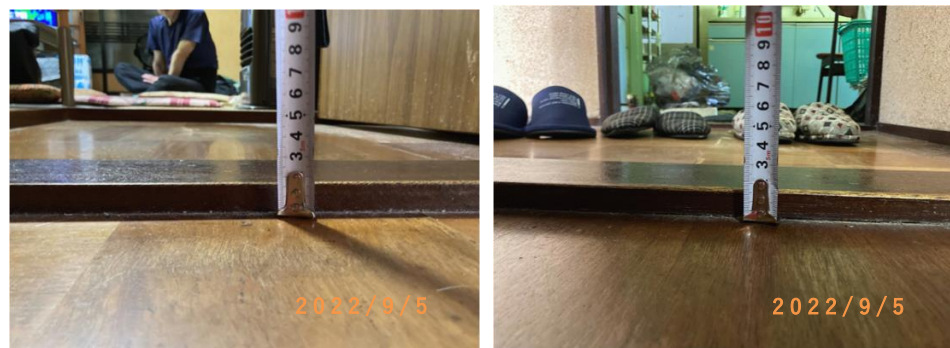
■段差確認■ (工事施工前)
