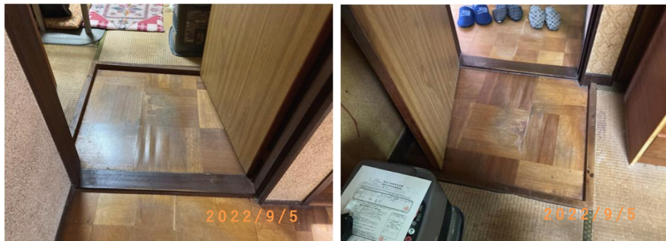
■現状写真■ (工事施工前)
