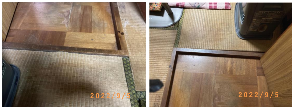
■現状写真■ (工事施工前)
