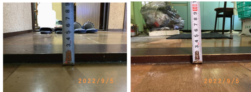
■段差確認■ (工事施工前)
