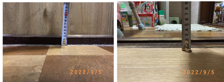
■段差確認■ (工事施工前)
