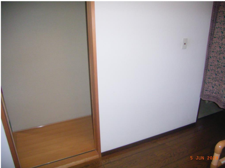
■現状写真■ (工事施工前)
