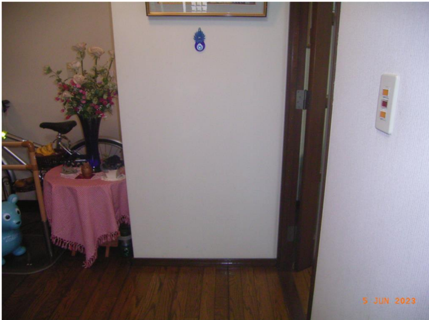
■現状写真■ (工事施工前)
