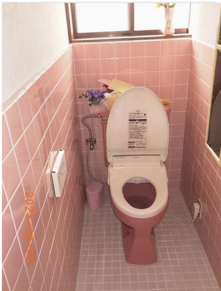
■現状写真■ (工事施工前)
