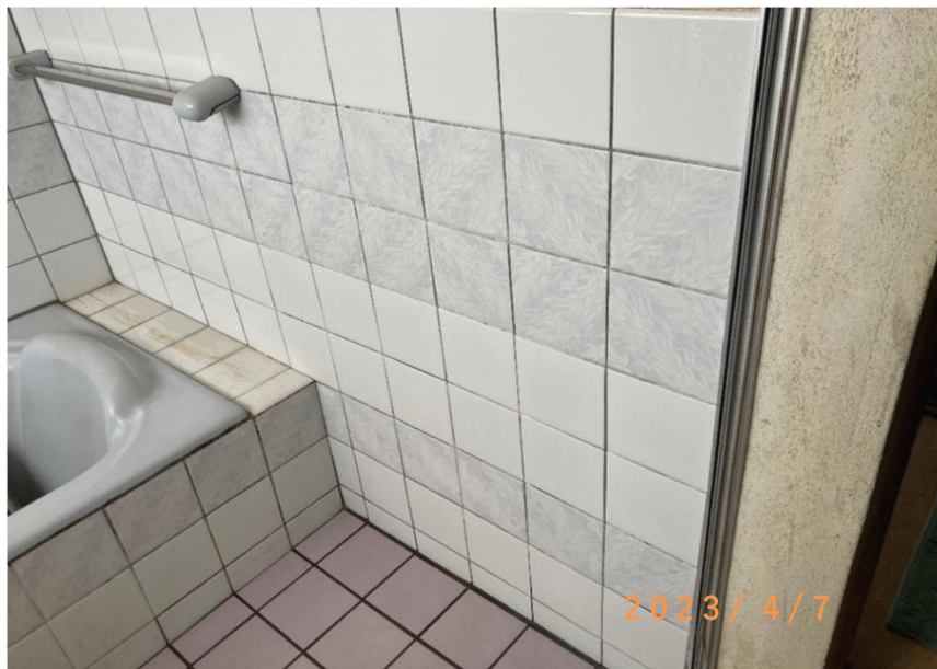
■現状写真■ (工事施工前)
