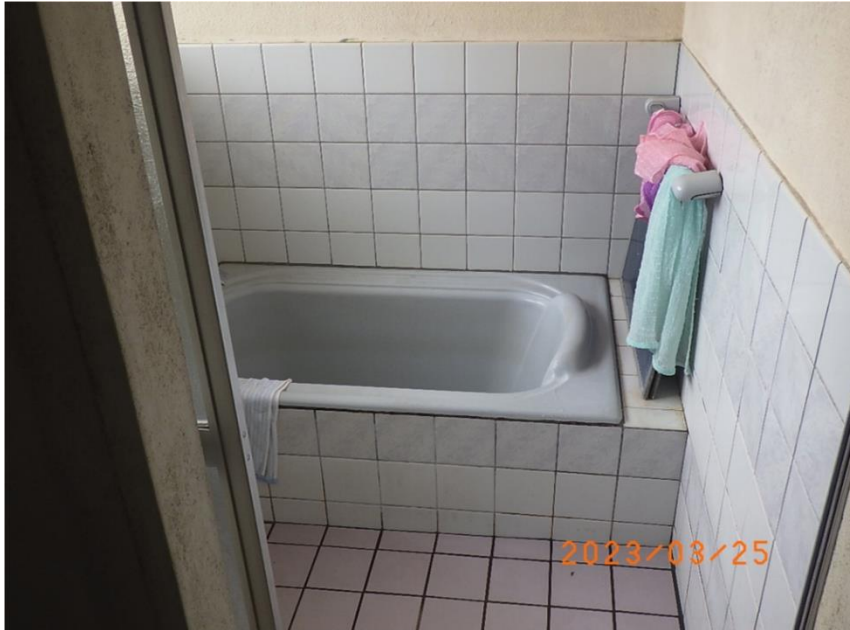
■現状写真■ (工事施工前)
