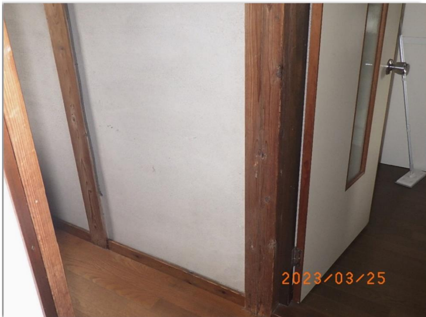
■現状写真■ (工事施工前)
