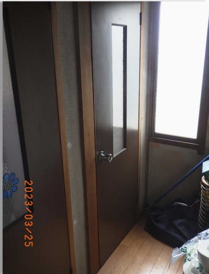
■現状写真■ (工事施工前)
