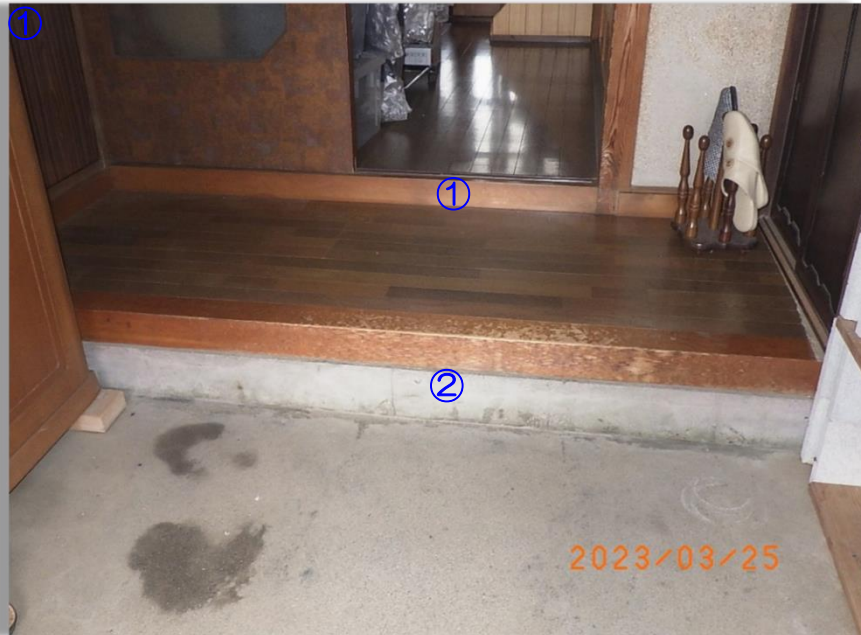
■現状写真■ (工事施工前)
