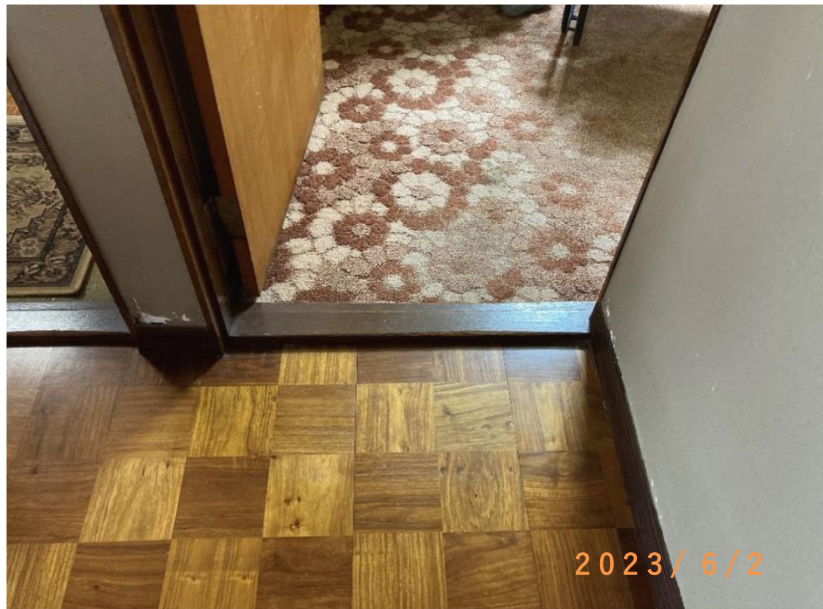
■現状写真■ (工事施工前)
