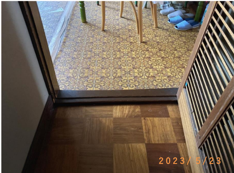
■現状写真■ (工事施工前)
