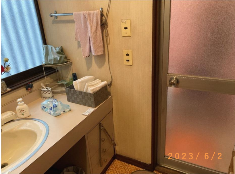
■現状写真■ (工事施工前)
