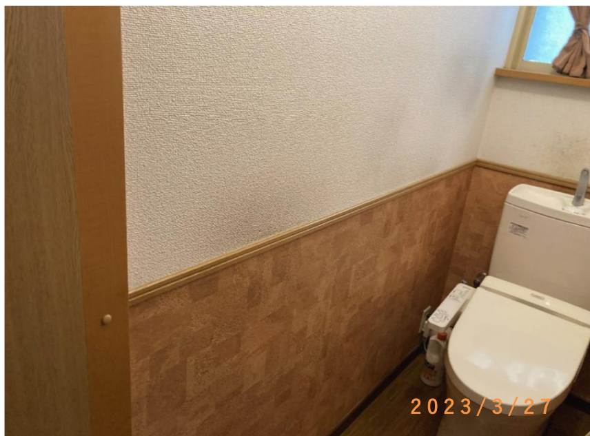
■現状写真■ (工事施工前)
