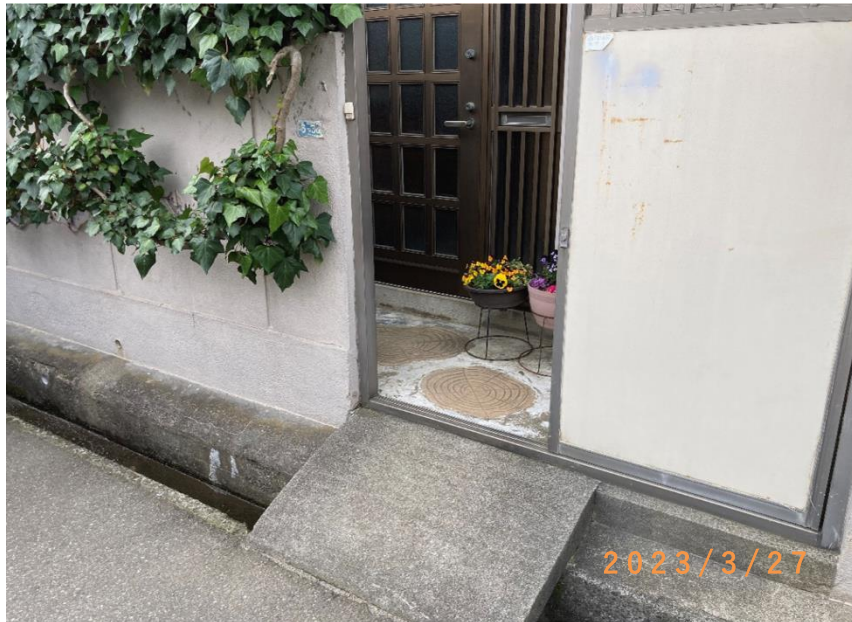
■現状写真■ (工事施工前)
